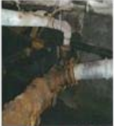
○給排水衛生設備
